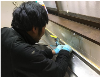
【施工後コメント】 新規 TOTO シングルレバー混合水栓
