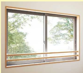
1 転落防止の手すりの設置
